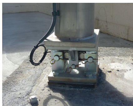
Szczegóły instalacji czujnika siły M460
