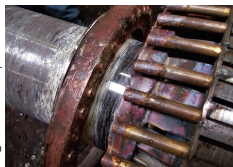
Rys. 7.18. Urywany pierścień klatki rozruchowej silnika o parametrach znamionowych: 200 kW, 1000 V, 1480 obr./min, 1290 N·m
