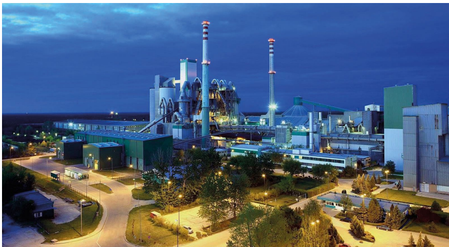
Zakład produkcyjny w Choruli. Widok nocą
