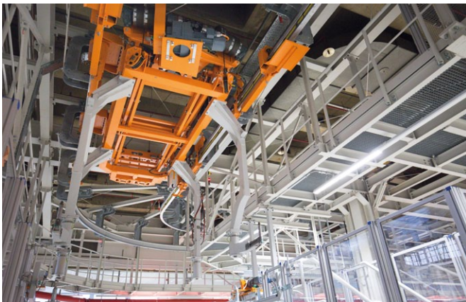
Fot. 1. Unikalne rozwiązanie w branży: dwutorowa kolejka podwieszana (EHB) z redundantnym napędem podnoszenia
