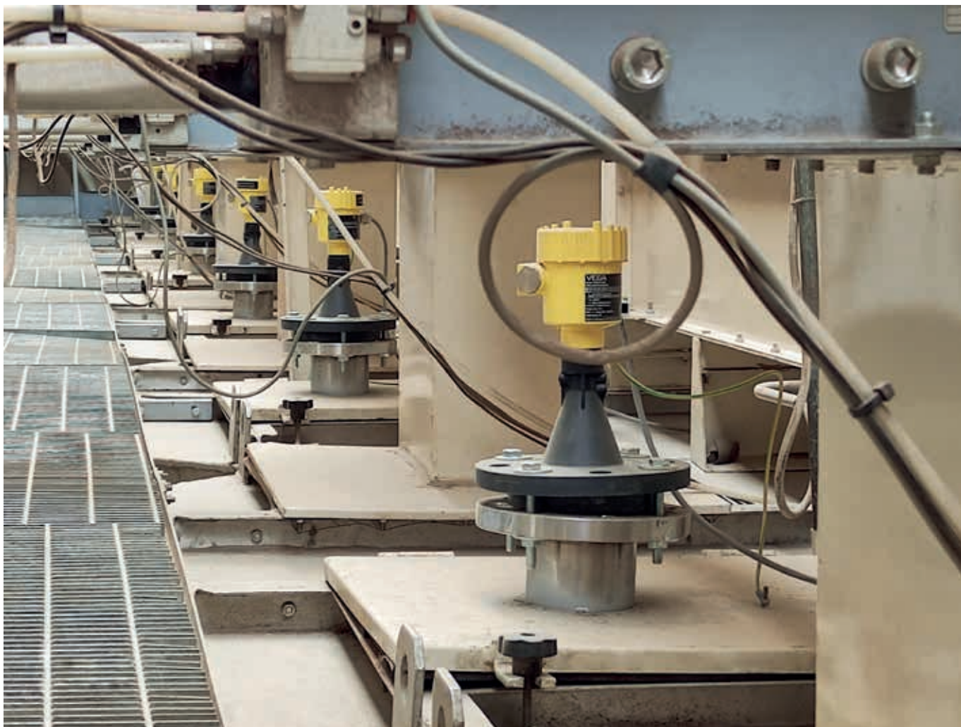
Zdj. 3: Częstotliwość 80 GHz zapewnia wysokie skupienie wiązki, co umożliwia zastosowanie sond nawet w silosach z konstrukcjami wewnętrznymi.
